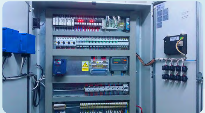
Automatizare unități de flotație ( DAF )
