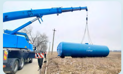
Rezervor subteran levigat 110 mc
