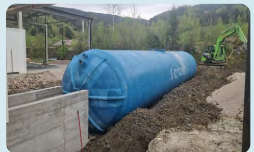
Rezervor subteran apă tehnologică 100 mc
