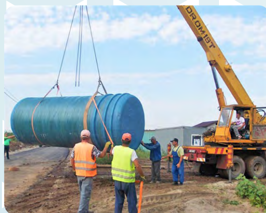
Stație de pompare Ø=2.5 m h=6 m
