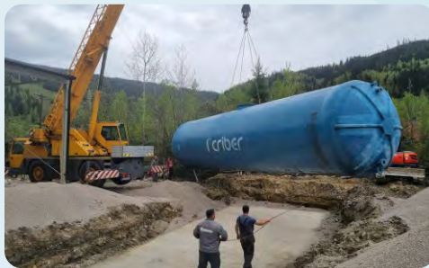
Rezervor subteran apă pluvială 115 mc
