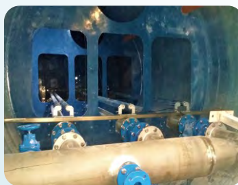
Conducte hidraulice din inox
